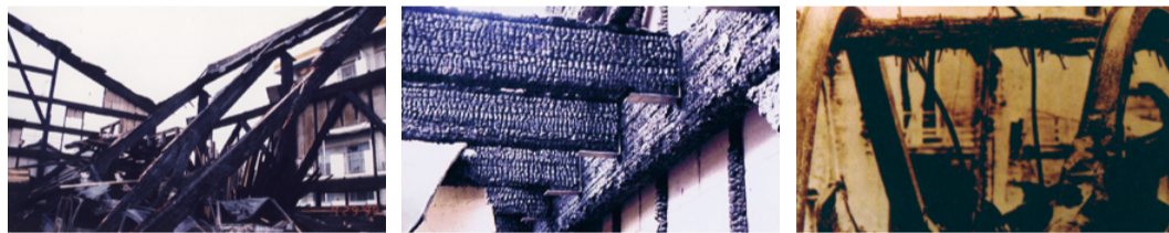
金物スリットのみ部位は崩壊 金物の受けサポートが建物の倒壊を防ぎました 鉄は500~800℃で軟化し、アメのように曲がってしまいます。
